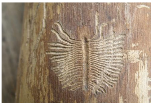
Рис. 1. Повреждение древесины короедом
